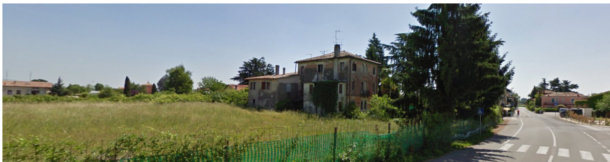
Vista da Via Pianale – sullo sfondo l'edificio esistente
