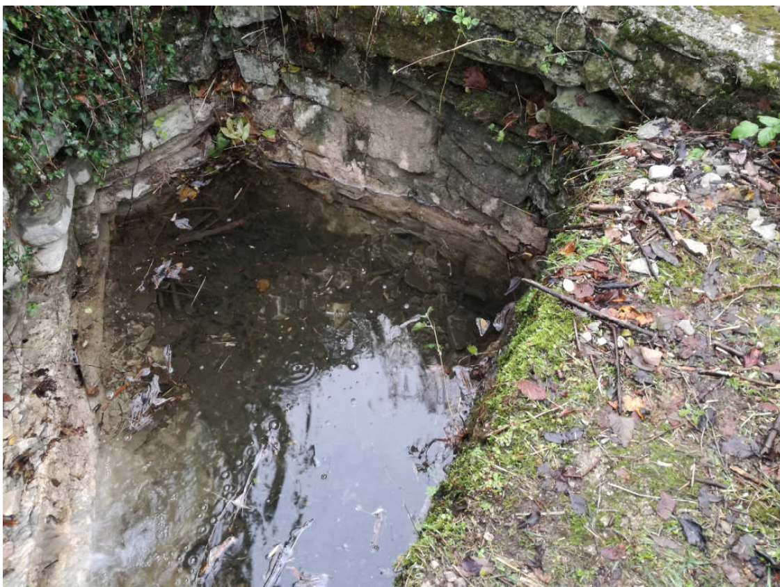
FOTO 2: Tombotto dopo l'intervento iniziale di pulizia (tubazione ancora ostruita da detriti)
