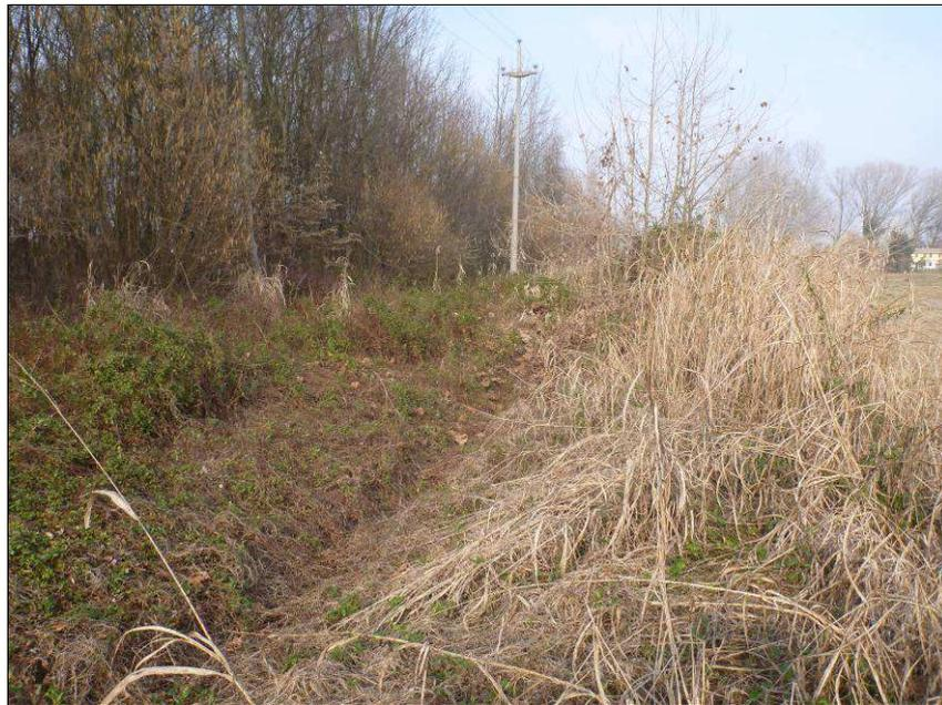
Figura 42. Stato attuale fossato a cielo aperto oggetto di futuro risezionamento e allargamento per funzioni di compensazione geometrica e di invaso il cui terreno adiacente, in destra idraulica, è di proprietà del lottizzante; vista in direzione nord.
