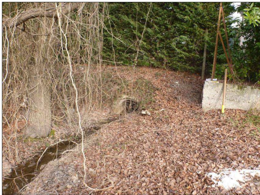
Figura 33. Sistema di smaltimento dell'intera rete attuale di fossi rappresentata da una tubazione circolare in cls Ø 80 cm; vista in direzione nord.
