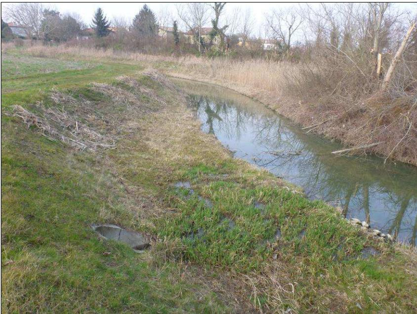
Figura 35. Immissione acque, a quota 7,99 m, nello "Scolo Noventana Nuovo" mediante tubazione  $\varnothing$  60 cm in cls; vista in direzione ovest.
