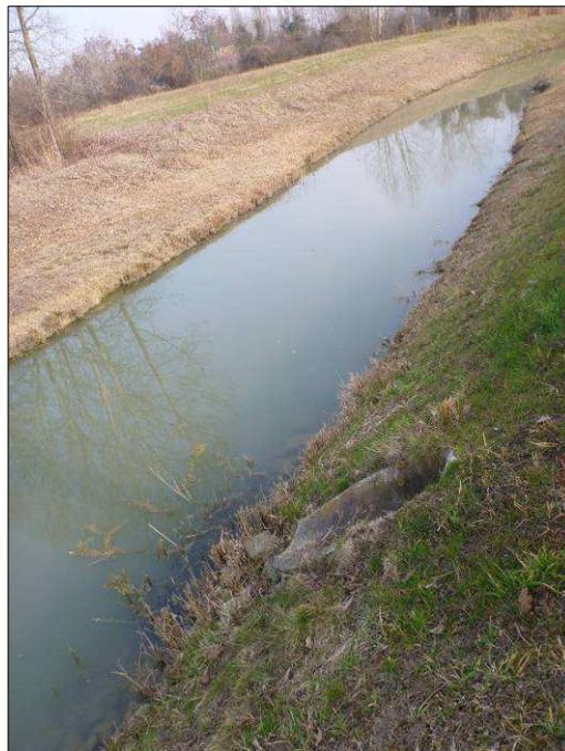
*Figura 44. Immissione acque fossato a cielo aperto oggetto di futuro risezionamento e allargamento per funzioni di compensazione geometrica e di invaso, a quota 8,14 m, nello "Scolo Noventana Nuovo" mediante tubazione Ø 60 cm in cls; vista in direzione est.*
