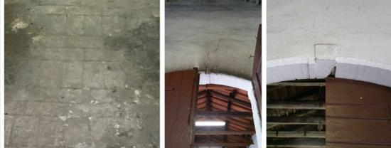
dettaglio pavimentazione interna    9 lesione muratura e pietra chiave della porta d'ingresso alla carbonaia
