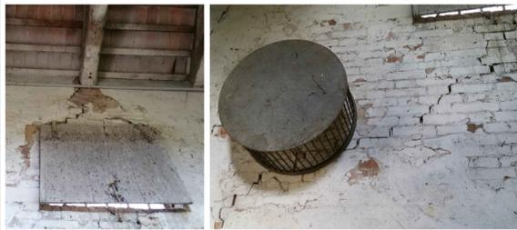
3 finestra con oscuro in legno interno, presenza di lesioni della muratura sia sottostante che sovrastante in corrispondenza della testa della trave
