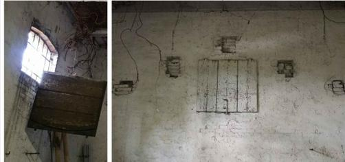
6 finestra con oscuro in legno    7 finestra tamponata con oscuro in legno circondata da vecchi punti di alloggiamento delle travi della copertura di un edificio limitrofo, sostituito con uno di maggiore altezza
