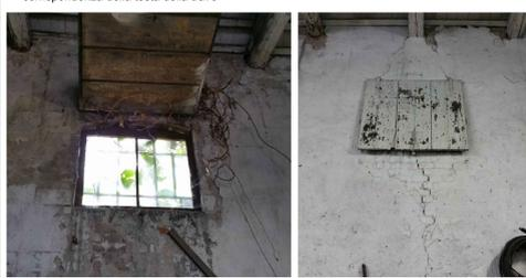
4 finestra con oscuro in legno, barre in ferro e infisso in legno    5 finestra con oscuro in legno interno, presenza di lesioni della muratura sia sottostante che sovrastante in corrispondenza della testa della trave
